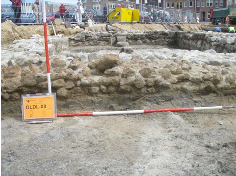
Afb. 12. De fundering uit brokken ijzeroer.
