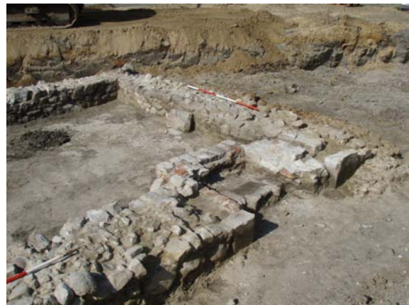
Afb. 11. Overzicht ter hoogte van de ingang.
